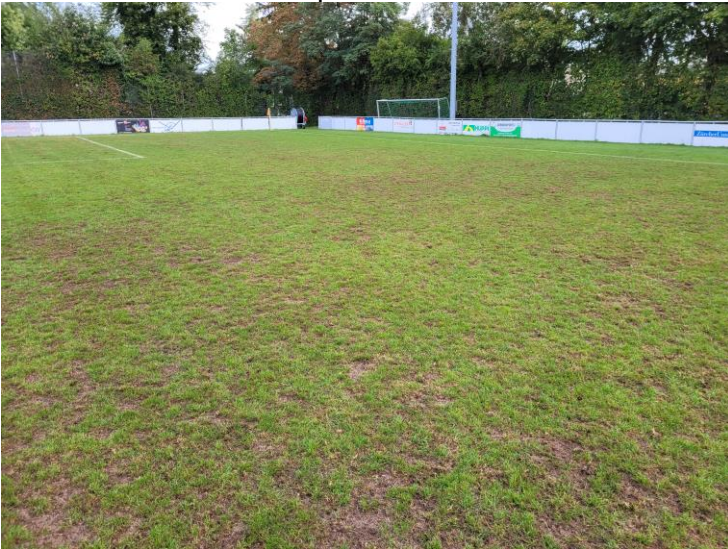
Narbenschäden durch Spielbetrieb
